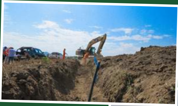
8. CULPÓN. Continúan las instalaciones en riego tecnificado.
